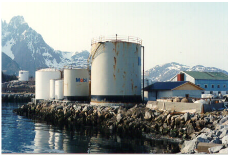
Figur 7.7: Ensileringsanlegget som ble bygget på Balstad i Lofoten. Lagertankene for ensilasje er brukte oljetanker.
