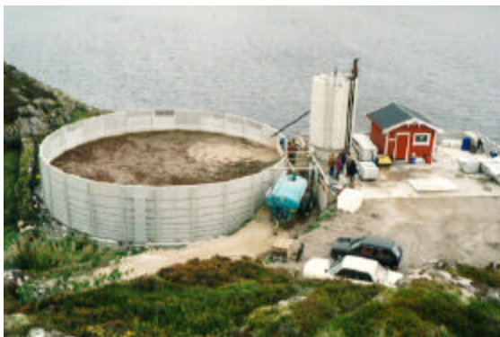
Figur 2: Komposteringsanlegg på Frøya
